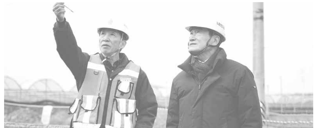
최기문 영천시장 금호대창 하이패스 IC 설치공사 현장방문
