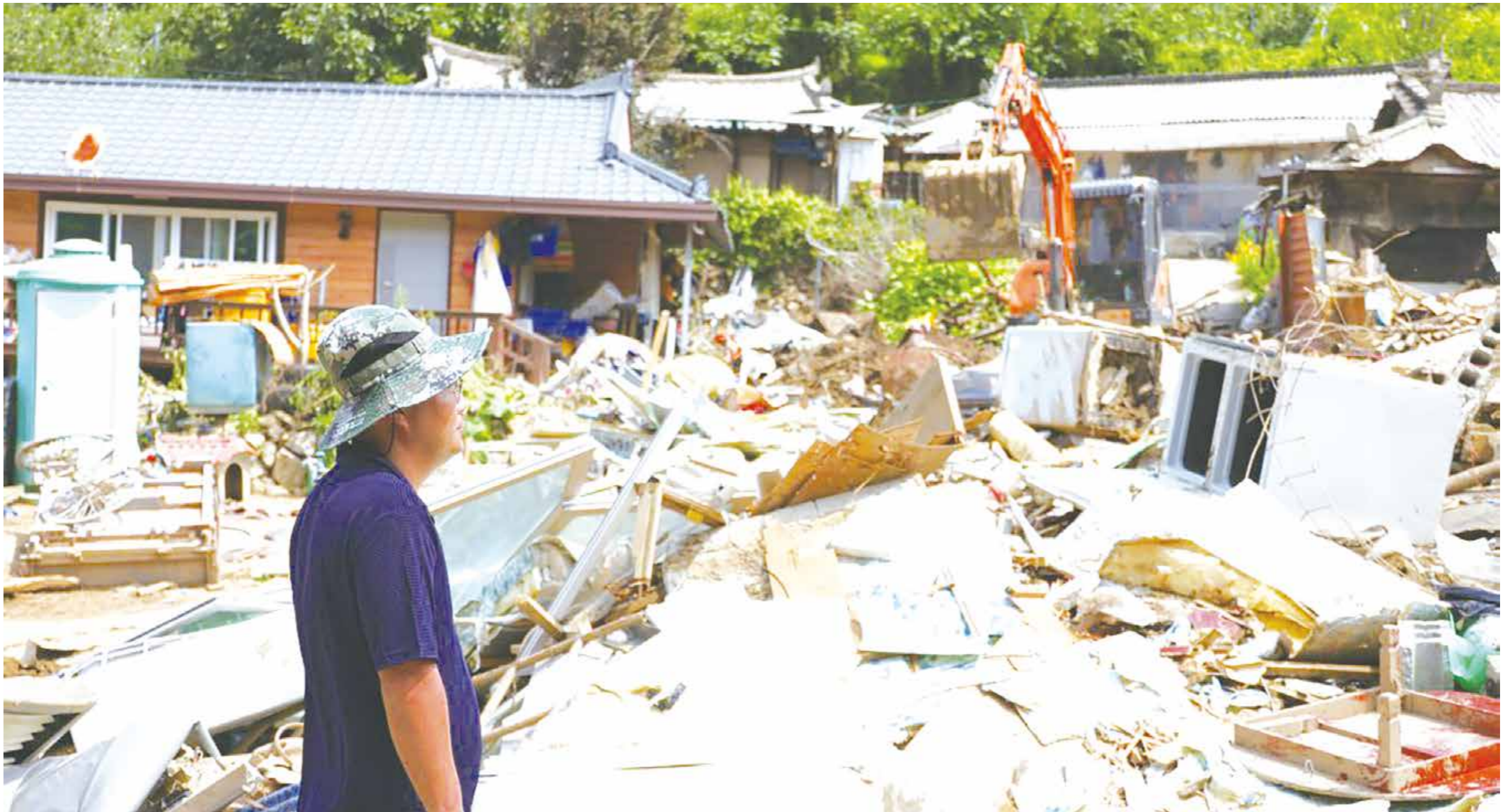
봉화군 봉성면 우곡리 오그래미 마을, 수해피해 복구 현장.
