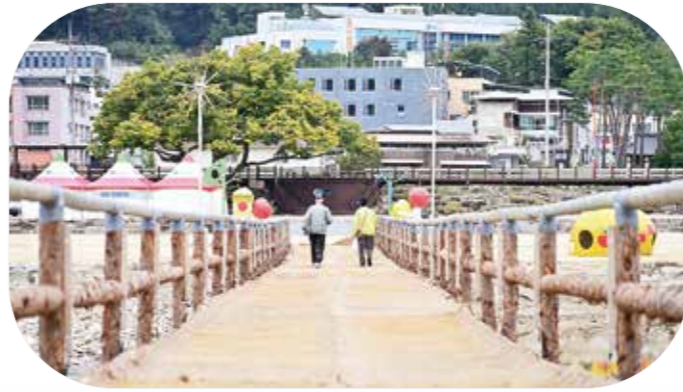
청송군, 용전천 현비암변에 섰다리 설치
