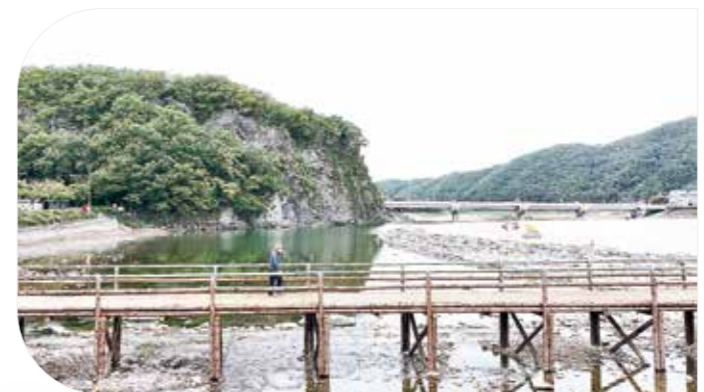
청송군, 용전천 현비암변에 섰다리 설치
