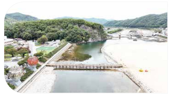
(청송군, 용전천 현비암변에 섰다리 설치
