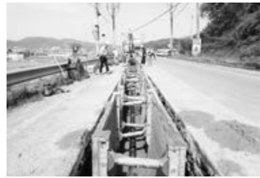
하수관로 정비공사 현장 모습.
