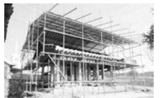
영주시 장수면 성곡리 안동권씨 검교공파 이맹공 사당 보수공사 장면.
